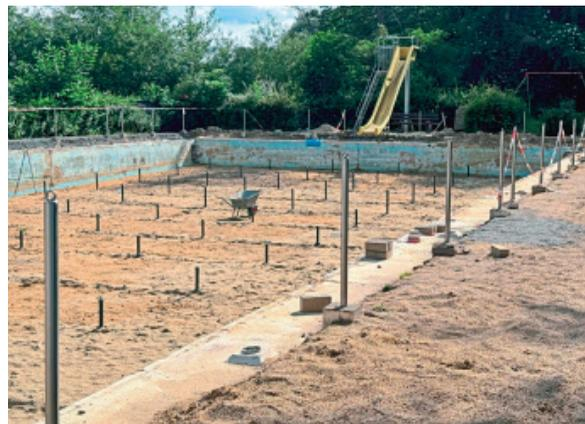
Eigentlich war geplant, die neuen Frischwasserrohre an die alte Frischwasserleitung anzuschließen. Doch dieser Plan scheiterte am massiven Fundament des früheren Beckens – eine Kernbohrung war nicht möglich.
